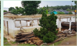
<건물 철거 모습(12)>
